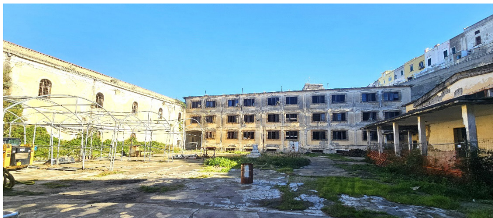
Fig.6 - Cortile dismesso del "Carcere Nuovo" di Terra Murata
